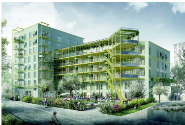
genossenschaftlicher Wohnungsbau im Holliger in Bern – in Ausführung
