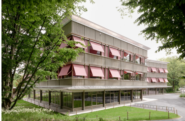
Erweiterung Schulhaus Marzili in Bern – abgeschlossen 2019
